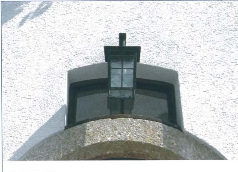
Kennzeichnend für den Haustyp II der Werksiedlung sind die fehlenden Fenster im Stiegenhausbereich. Eine Oberlichte mit Eingangsbeleuchtung tritt an deren Stelle.
