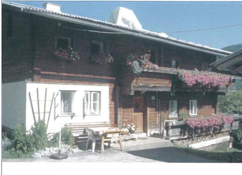
Unter der Verschalung und Dämmung ist noch der alte Holzblockbau erhalten.
